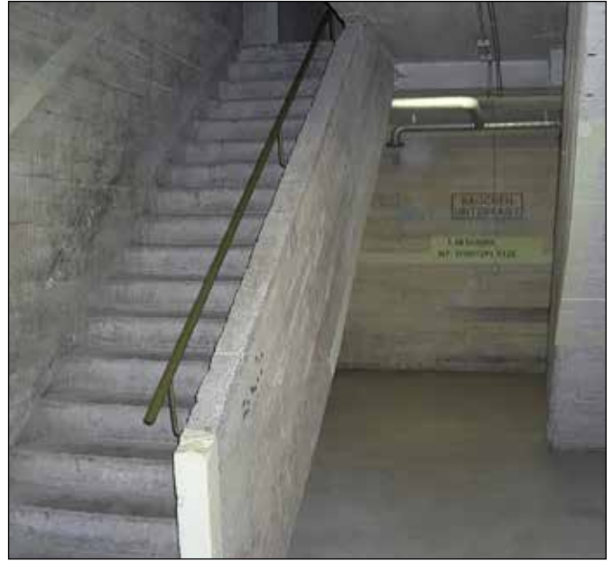
Im Innern des Hochbunkers Kuhnsweg (Foto: Hartmut Ring)
